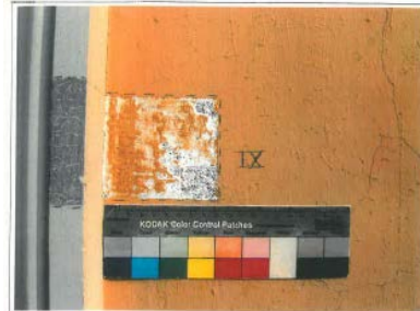
Tassello IX , fondo facciata (interno cortile).
